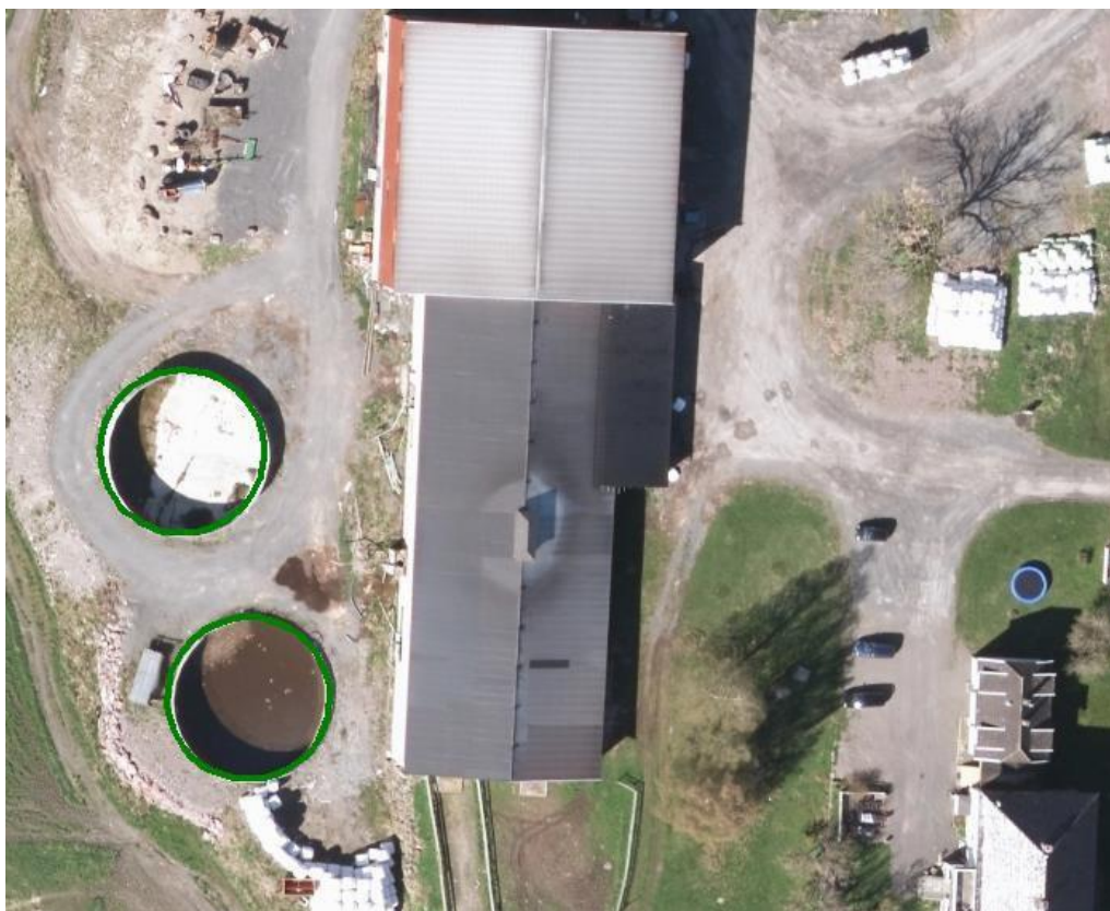
Eksempel på registrering av åpen gjødselkum som MurFrittstående.
