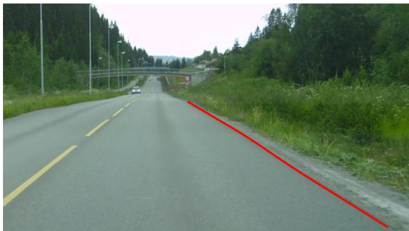
Eksempel på registrering av Vegdekkekant (asfaltkanten registreres – rød linje).
