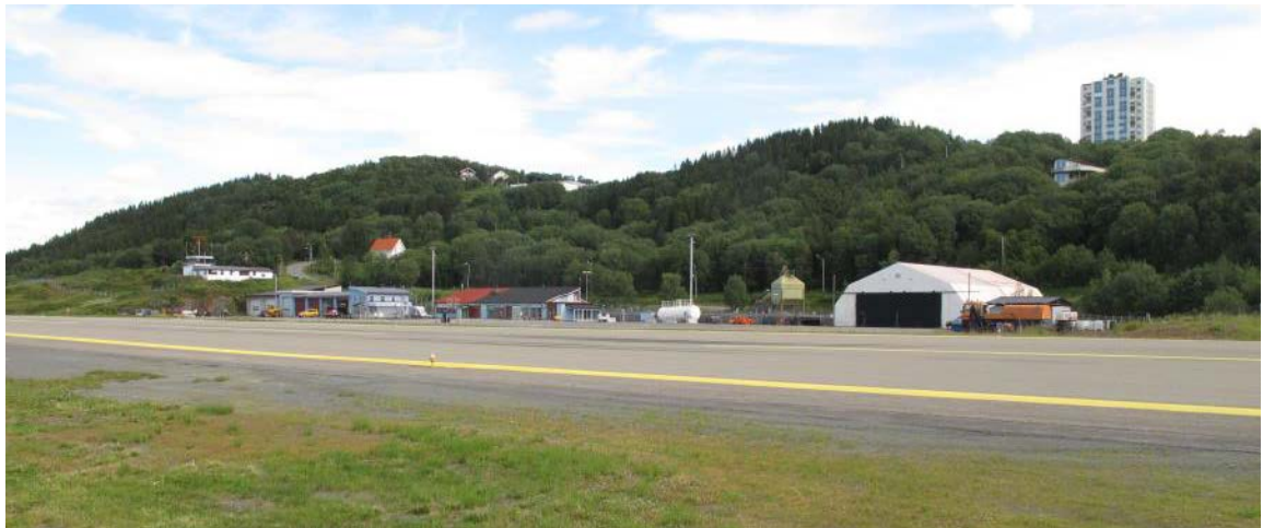
Figur 1. Terminalbyggene ved Narvik lufthavn. Foto: Rune Solvang.
