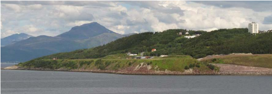
Figur 4. Lufthavna ligger på planerte løsmasser. På vestsiden er det en bratt skrent ned mot sjøen. Foto: Rune Solvang.
