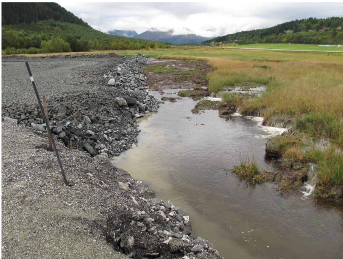
Figur 13. Ny massefylling i våtmarkssystemet (til venstre) og erosjon i myra (til høyre) etter forstyrrelsen i vannbalansen. Foto: Heiko Liebel.
